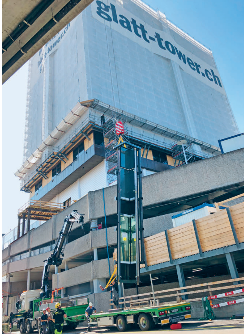
Ein 9 m hohes, verglastes Eckelement wird an seinen Zielpunkt gehievt.
